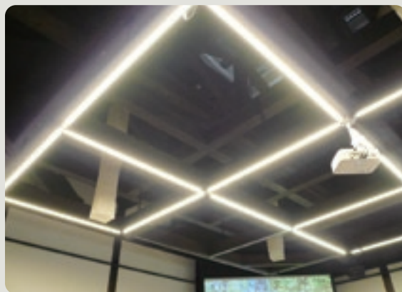
天井梁に直接取り付け付けた施工事例(鳥取市鹿野往来交流館)
